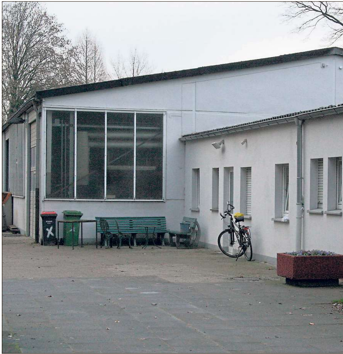
Der Abriss des bisherigen Bauhofs an der Lütgenbreite wird deutlich teurer als geplant. Der Grund: die Entsorgung der Thermohaut eines neueren Werkstattanbaus und die möglichen Altlasten in den Verfüllungen des Abbrocksbachs, der einst über das Bauhof-Gelände führte. Bilder: Aundrup
